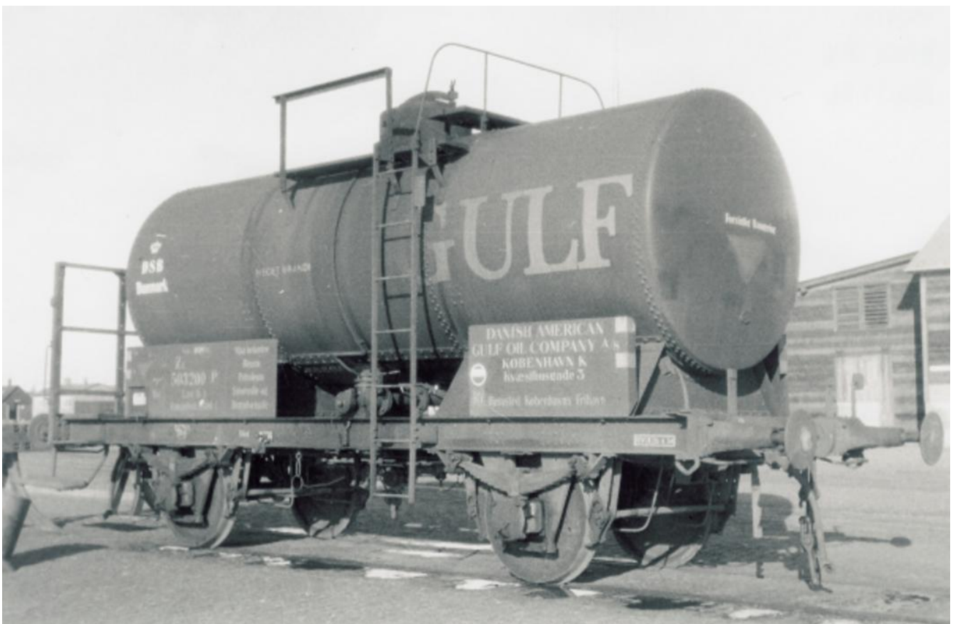
ZE 503 200. I Esbjerg, 1958. Vognen er bygget i 1922 og må høre til de første med tank samlet af 3 svøb. Tillig og Fleischmann modellerne har 1,5 mm. for stor akselafstand, læg lige mærke til det enorme gelænder på bremseplatformen. Foto.: Poul Egon Clausen. Arkiv DMJK.
